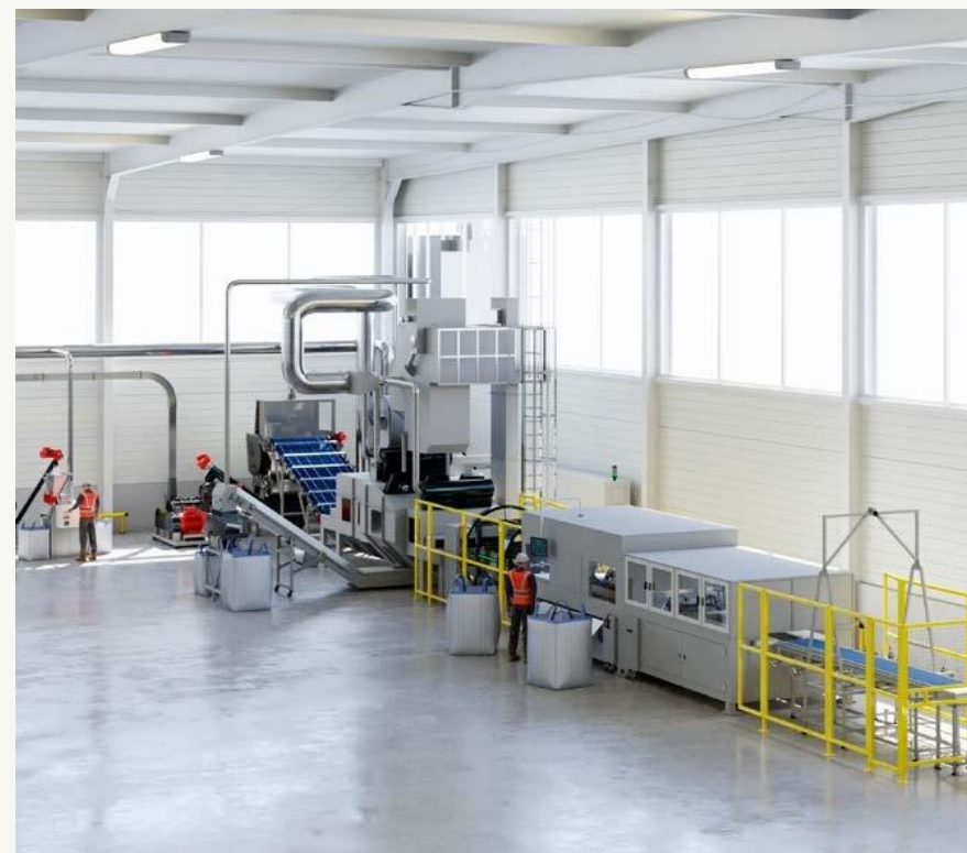
Linea automatizzata per il riciclo fotovoltaico
